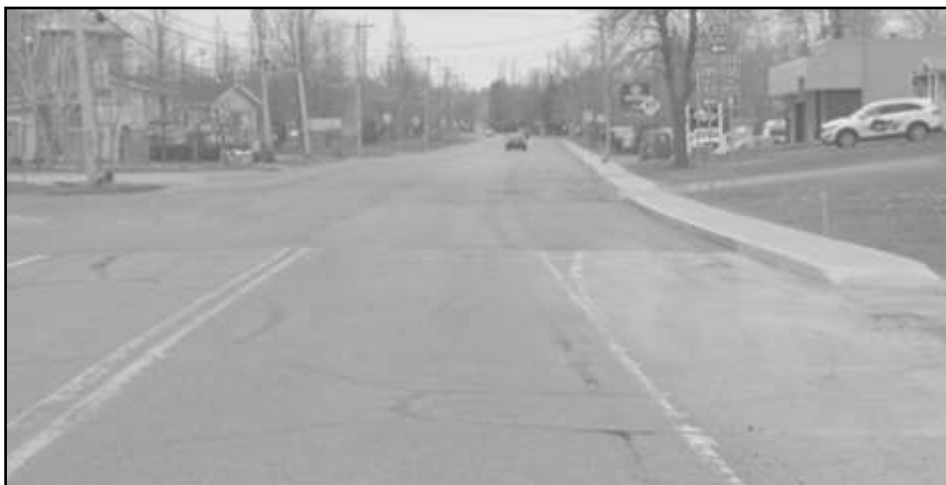
La route 132 Ouest, à partir de l'intersection du boulevard Nilus-Leclerc, enfin pavée. Photo : Guy Laprise.
