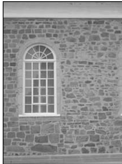
Sur le mur sud de l'église, une démarcation dans la taille des pierres marque l'endroit où se trouvait la façade originale. Photo : Tristan Morin.
