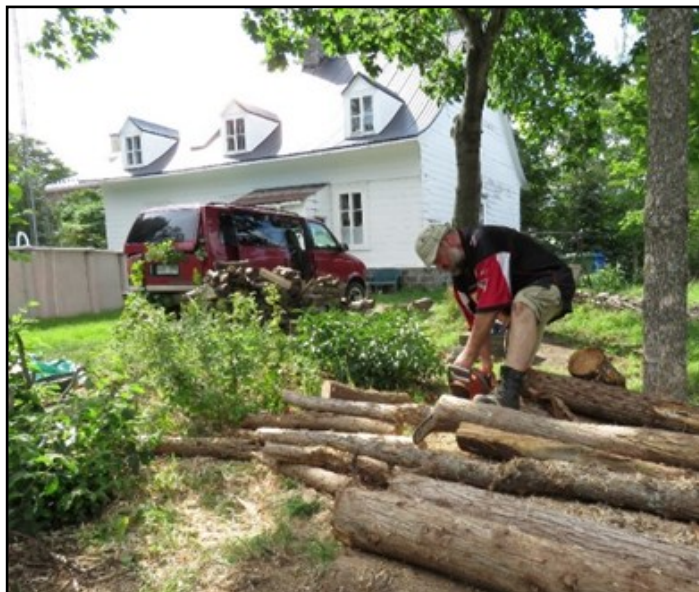
Jérôme, l'homme qui plantait des pieux... avec le sourire. Fier de refaire la clôture de la Maison Dion. Photo : Maison Dion.
