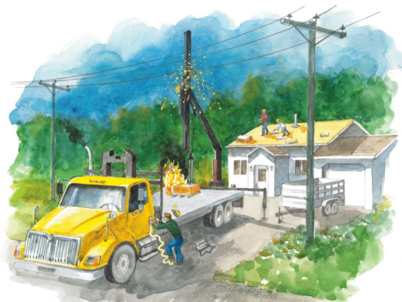
Camion sous tension. Illustration : CNEST.
