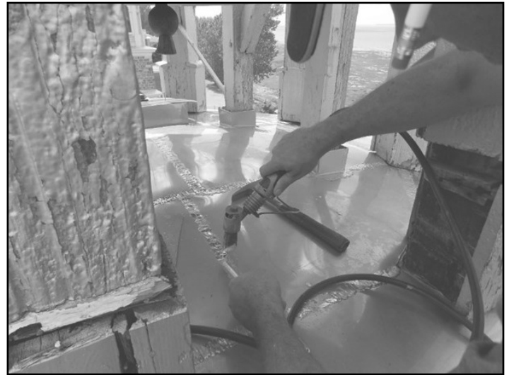
Le tôlier effectuant les soudures du plancher du clocheton. Photo : Conrad Caron.
